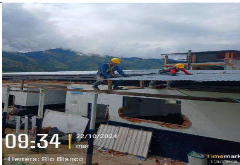
*Imagen 4 Desmonte, Cargue y Retiro de Cubierta*
