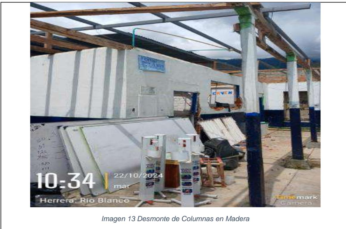
*Imagen 13 Desmonte de Columnas en Madera*
