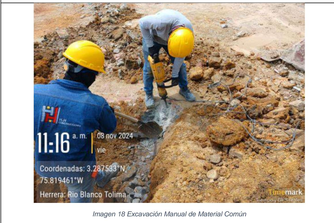
*Imagen 18 Excavación Manual de Material Común*
