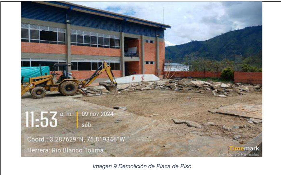
Imagen 9 Demolición de Placa de Piso
