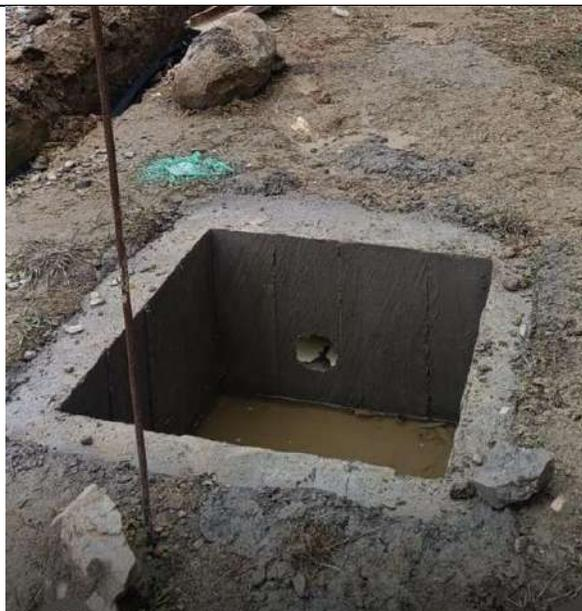
*Imagen 30 Construcción de cajas de inspección*
