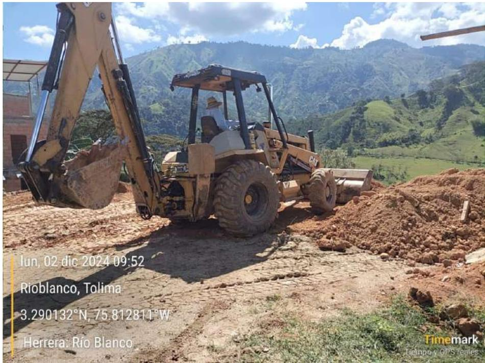
*Imagen 22-23 Cargue, Retiro y extendida de Material de Excavaciones*
