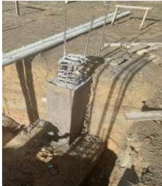
*Imagen 26-27-28-29 Acero figurado y construcción de zapatas*
