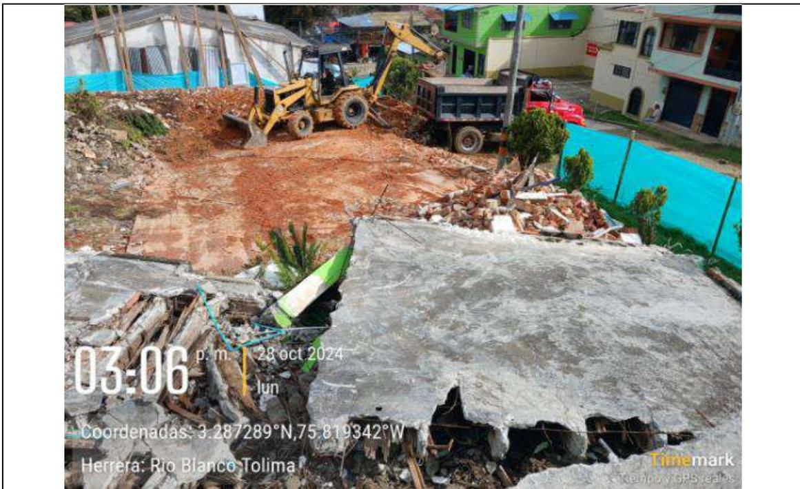
Imagen 5 Demolición de Placa de Entre Piso
