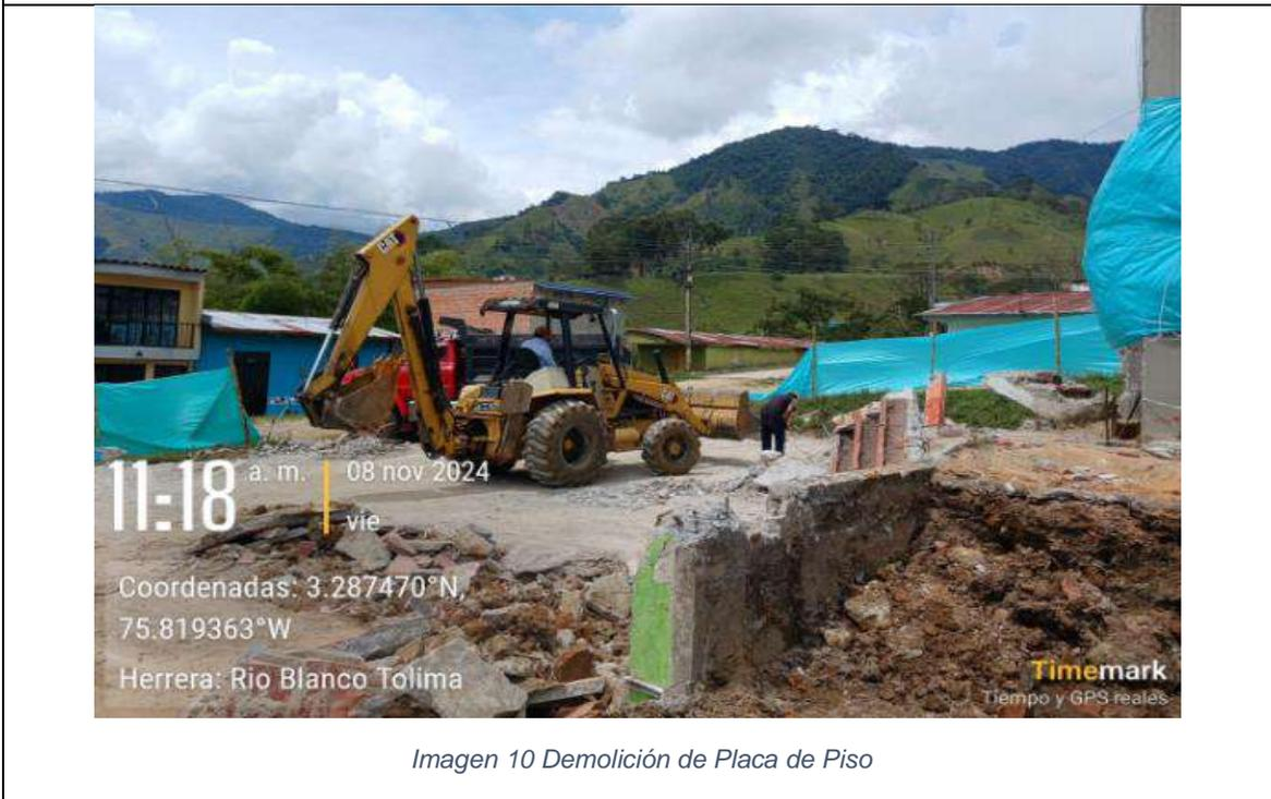
Imagen 10 Demolición de Placa de Piso
